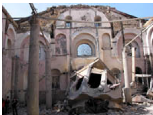
Den serbisk-ortodoxa katedralen St George från 1800-talet brändes ut fullständigt och taket kollapsade.
