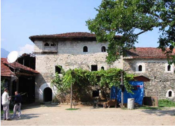
Kulla Kuklecve i Isniq, fasad mot söder. Foto Dick Sandberg 2001.
