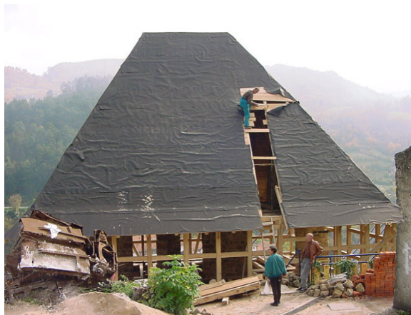
Takläggningsarbete. Foto Robert Stergar, oktober 2002.
